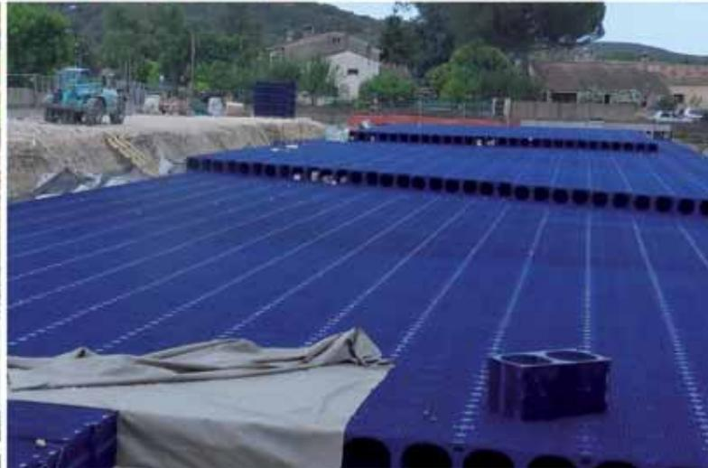
Afin de limiter le ruissellement, des bassins de stockage enterrés permettent de récupérer les eaux de pluie d'un quartier. Ces bassins peuvent être conçus grâce à des structures alvéolaires ultralégères (Saul).
