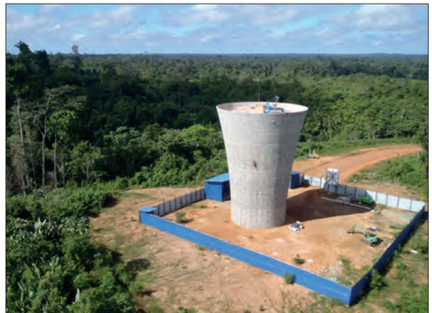
S'agissant des matériaux, le sable et le gravier ont été extraits dans le fleuve Maroni par une barge artisanale. Malgré les risques d'hétérogénéité des matériaux, l'équipe d'Eiffage TP a mis au point une formule de béton permettant d'obtenir une résistance de 30 MPa avec une bonne fiabilité. Cette formule a cependant nécessité, pour compenser le manque d'éléments fins du sable de rivière, l'approvisionnement du chantier en sacs de filler depuis la métropole.
