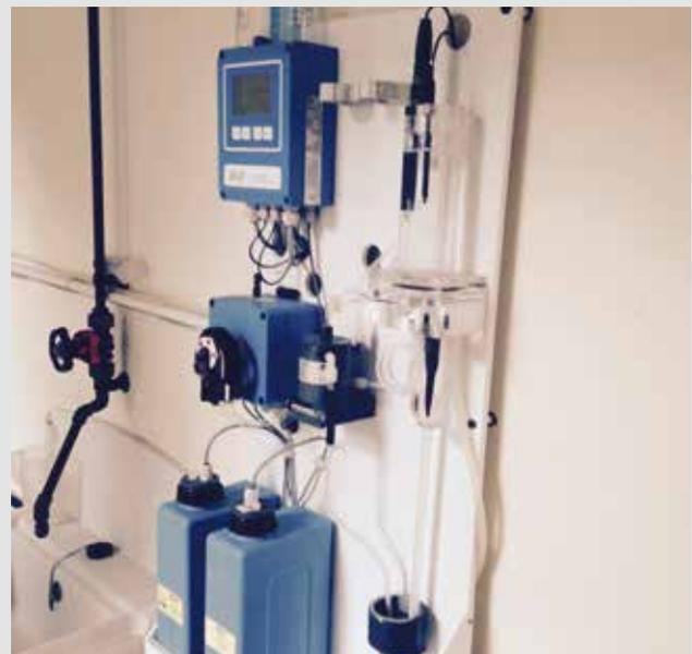
Swan commercialise aujourd'hui un instrument, l'AMI Codes-II CC, capable de mesurer les chloramines dans les piscines
