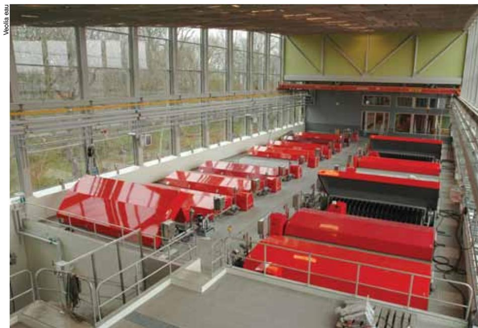
Les 32 filtres Hydrotech installés assurent un traitement au maximum de 28 800 m<sup>3</sup> par heure.
