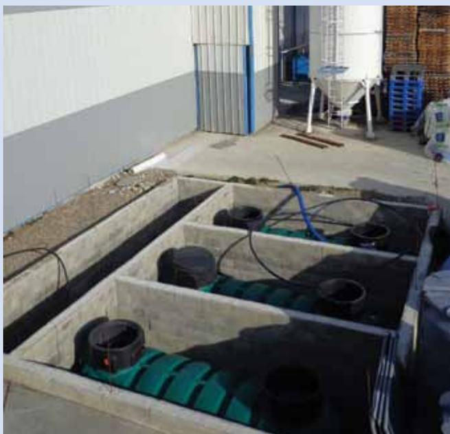
Trois cuves de 10 m<sup>3</sup> récupèrent les eaux de pluie pour les besoins en refroidissement d'une installation industrielle.
