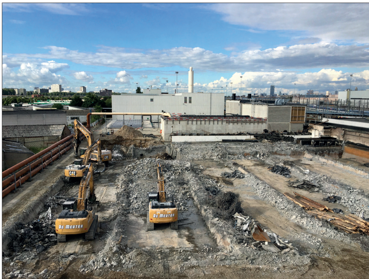
Démolition de la phase B
