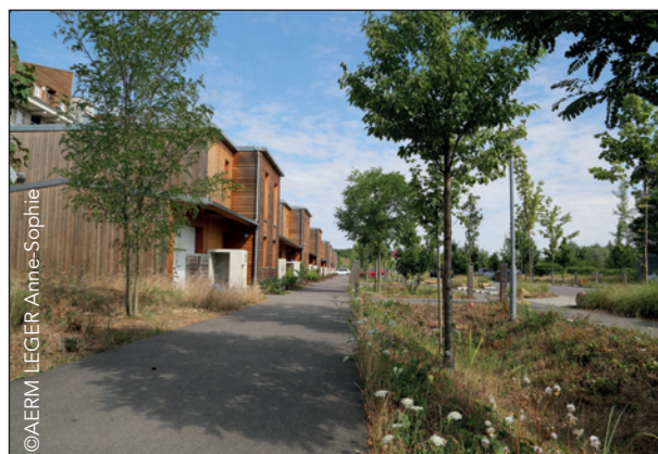
Gestion intégrée des eaux pluviales. Noues dans l'écoquartier du plateau de Haye à Nancy (55)
