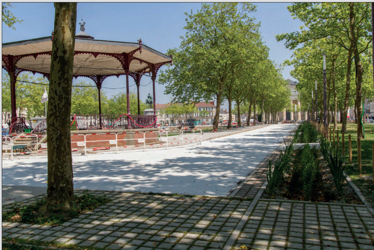
Place Napoléon La Roche-sur-Yon : aménagement de voirie pour maîtriser le risque de ruissèlement. Architecte Alexandre Chemetoff & Associés
