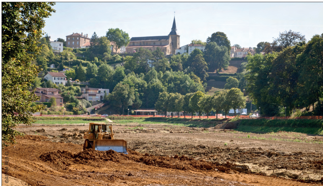
Travaux de réaménagement du plan d'eau de la Sangsue à Briey (54)
