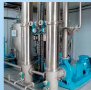
Réacteur biologique avec séparation des boues par membranes d'ultrafiltration
