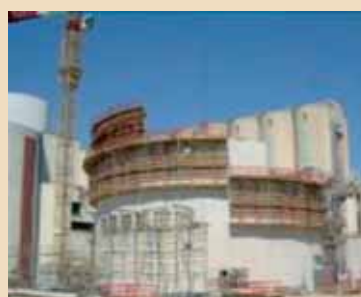
Pour la production de treillis soudés, comme ici pour la construction d'une station d'épuration, la livraison des matières premières par rail représente une économie de 440 camions par mois pour SOTRALENTZ Construction.
