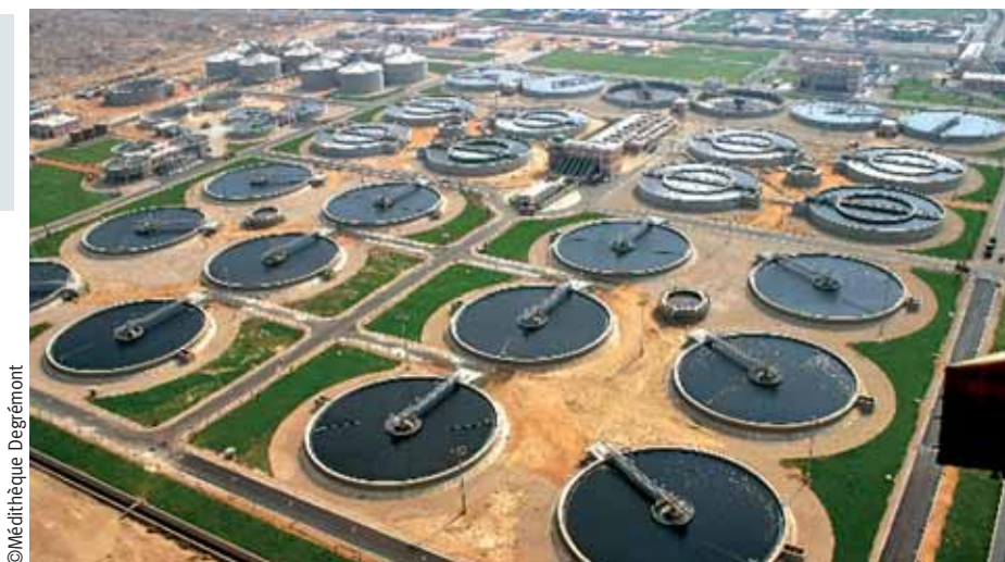
Le Caire - Station de Gabal El Asfar, station d'épuration la plus importante d'Afrique
