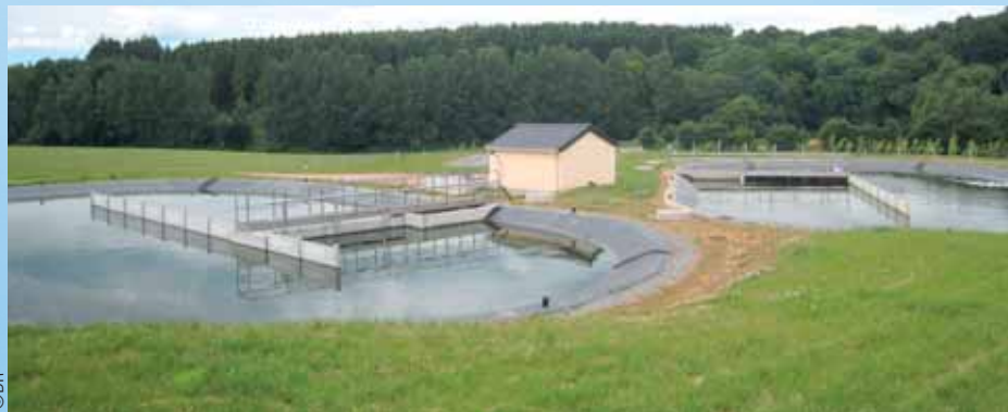
Lagunage aéré par insufflation d'air (OXYLAG®)
