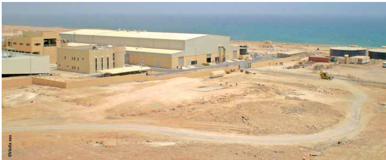
Vue extérieure du hall de membranes d'osmose inverse.
