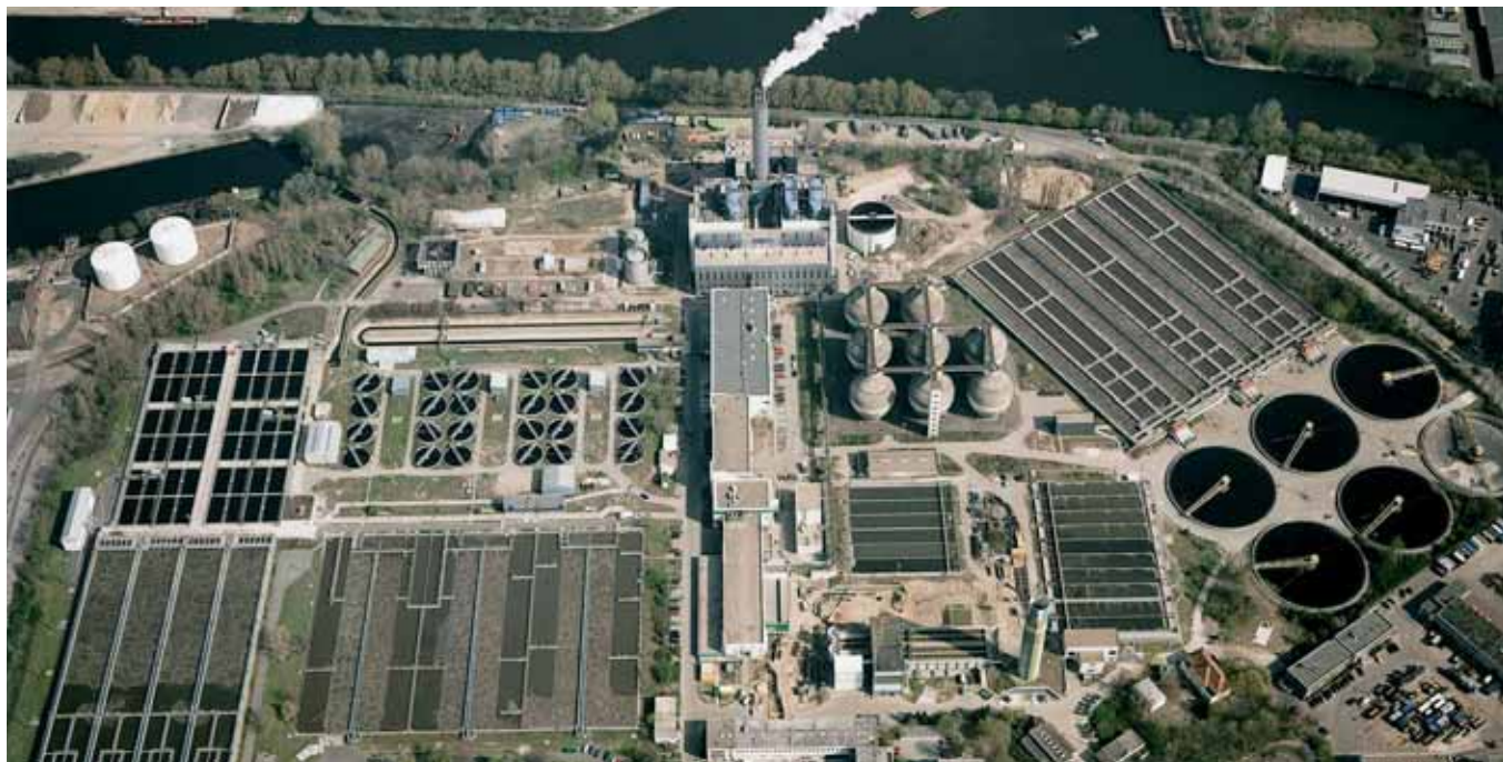
Station d'épuration de Ruhleben (Berlin)
