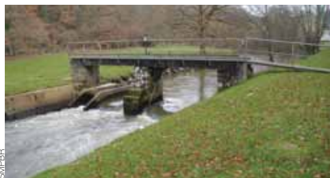
Captage sur le Couesnon.
