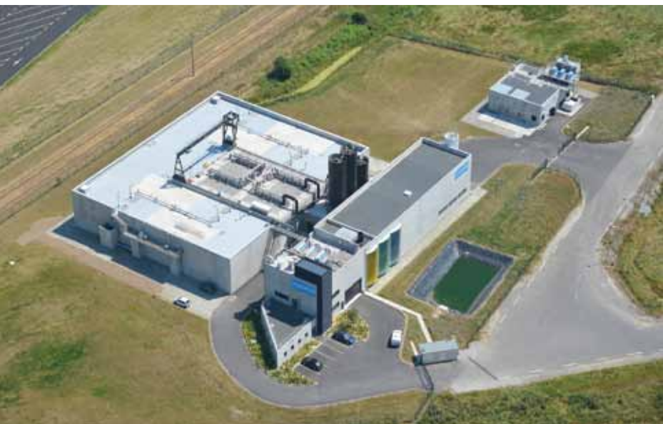
La nouvelle station de Montoir-de-Bretagne prend en charge les eaux usées de cinq communes avoisinantes (75 000 EH) ainsi que les eaux de lavage des quais du terminal multivrac du port.
