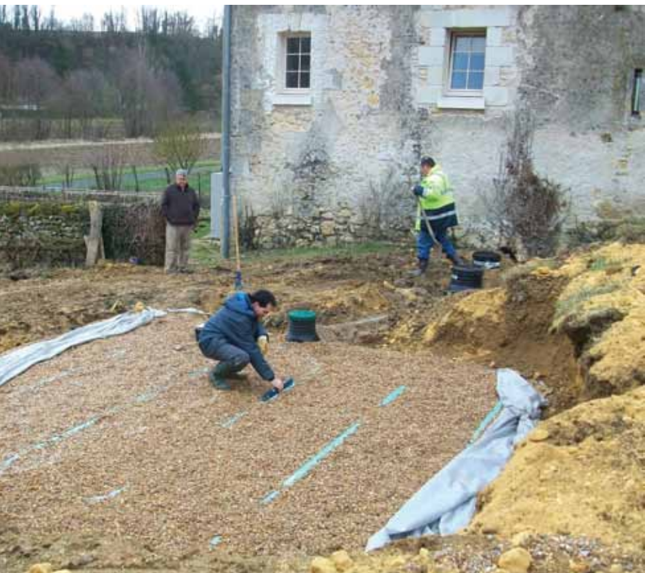
Lors de la mise en place d'un dispositif d'ANC, le Spanc peut contrôler la réalisation des travaux. Dans cette situation, il vérifie le degré de la pente d'épandage.
