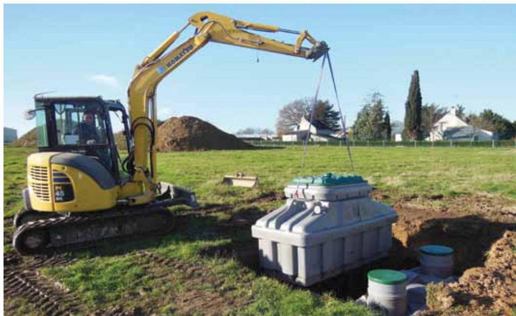
Installation du filtre compact Ecoflo de Premier Tech Aqua, qui utilise des fragments de coco comme média filtrant.
