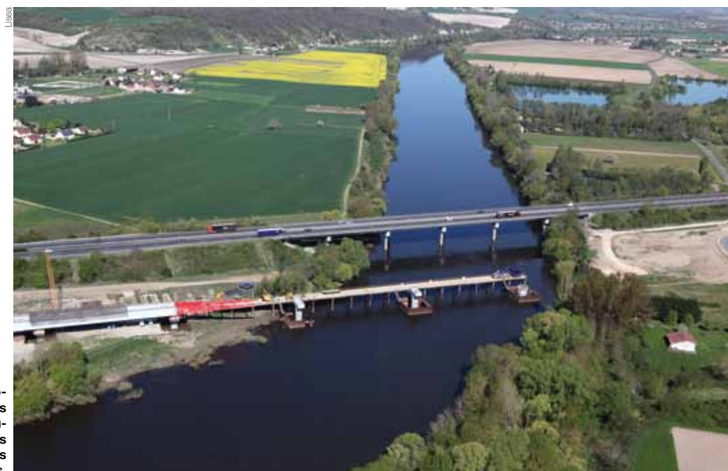
Pour garantir la transparence écologique de la ligne, les ouvrages construits doivent assurer le libre écoulement des eaux et sont donc conçus de manière à maintenir les conditions hydrauliques initiales recensées.
