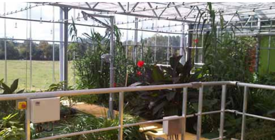
La future station de Boulazac, dans le Périgord, sera équipée de la solution Organica qui associe des bactéries libres (boues actives) et des bactéries fixées sur les racines des plantes.
