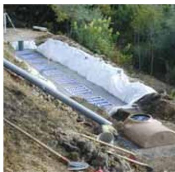
Le septodiffuseur, permet de réduire les surfaces d'épandage. La filière de traitement est alors plus compacte ; là où un filtre à sable demande une surface de 25 m<sup>2</sup>, 5,2 m<sup>2</sup> suffisent. Si le CSTB a testé l'efficacité du septodiffuseur et l'a classé parmi les moyens techniques performants en lui délivrant un Avis technique, la réglementation française l'ignore encore.
