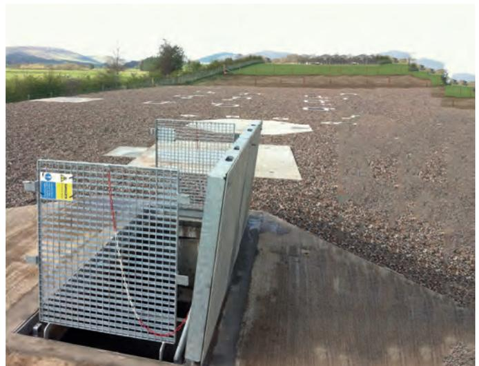
\*Étanche sous 150mm d'eau (essais réalisés par l'APAVE)
