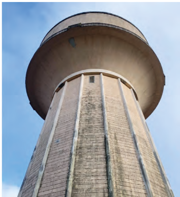
Exemple : Réservoir de Verthamon, à Pessac (33) Maître d'ouvrage : Suez Eau France
