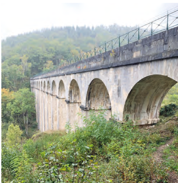
Exemple : Aqueduc de Montreuillon (58) Maître d'Ouvrage : Conseil général de la Nièvre
