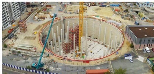
Le gigantesque projet de refonte de cette usine comprend notamment la construction d'un nouveau bassin de stockage de 70 000 m<sup>3</sup> pour les eaux excédentaires en temps de pluie, la modernisation de l'unité de prétraitement actuelle et la construction d'une seconde unité.
