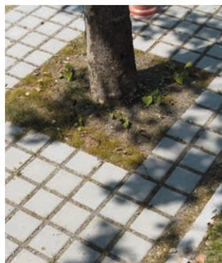
Le pavé drainant Ecoroc® est un pavé avec écarteurs intégrés qui garantit des joints élargis pour répondre aux contraintes urbaines et environnementales d'infiltration de l'eau de pluie. Le pavé drainant Ecoroc® bénéficie d'un marquage NF EN 1338:2004 garantissant par essai les performances hydrauliques d'infiltration.
