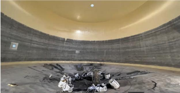
Le système d'étanchéité époxy Bioperl a été appliqué dans 11 digesteurs de 12.000 m<sup>2</sup>.
