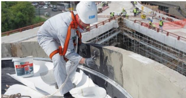
LANKOSTRUCTURE CARBOGRID a pour principe de fournir un renforcement structurel uniformément réparti sur la structure en appliquant du mortier et en incorporant une grille bidirectionnelle de fibre carbone dans le mortier. Parexlanko propose deux systèmes. L'un, « mince » développé pour le renforcement des ouvrages en béton armé, titulaire d'un Avis technique délivré par le CSTB.
