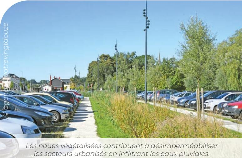
Les noues végétalisées contribuent à désimpermeabiliser les secteurs urbanisés en infiltrant les eaux pluviales.
