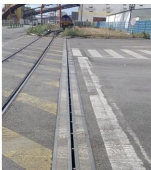
Le caniveau hydraulique à fente CF-Forté de Stradal conçu pour être mis en œuvre dans des zones de circulation à très fortes contraintes de poids, de fréquences de circulation, de freinages et de girations, est particulièrement adapté au passage des avions et
