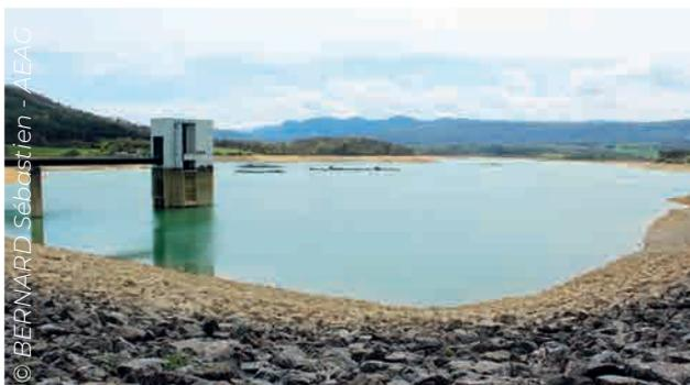
Sécheresse hivernale au lac de Montbel (Ariège) : vue sur l'écrêteur, évacuateur de crue de type puits
