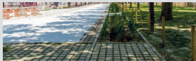
Pavés drainants, pavés à écarteurs Ecoroc de Stradal Place Napoléon, La Roche sur Yon (85)
