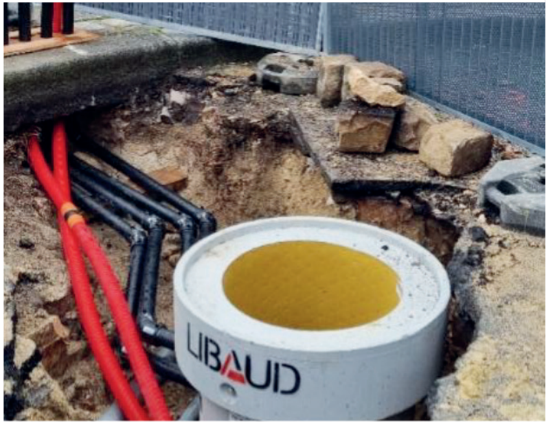
Pose et raccordement de regard de transfert
