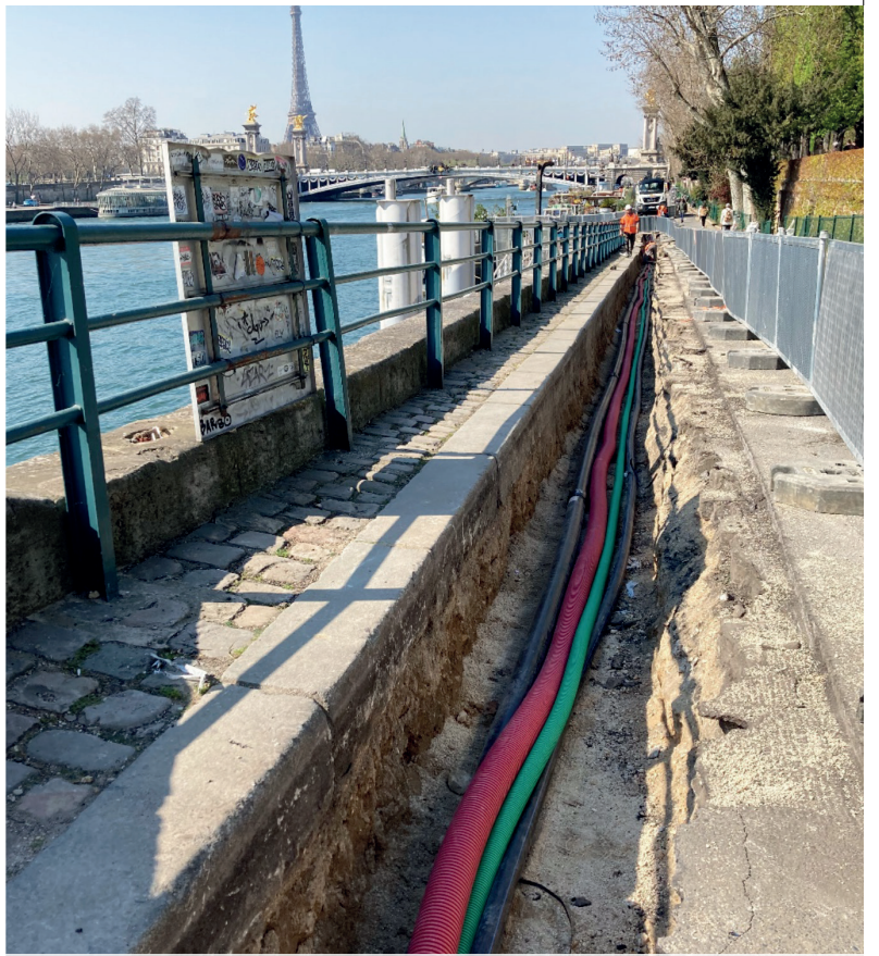
Pose du réseau de refoulement sur le port des Champs Élysées
