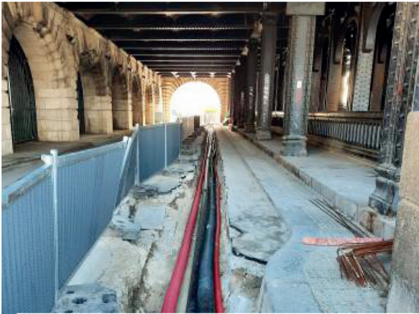
Pose du réseau de vide sous le pont Alexandre III
