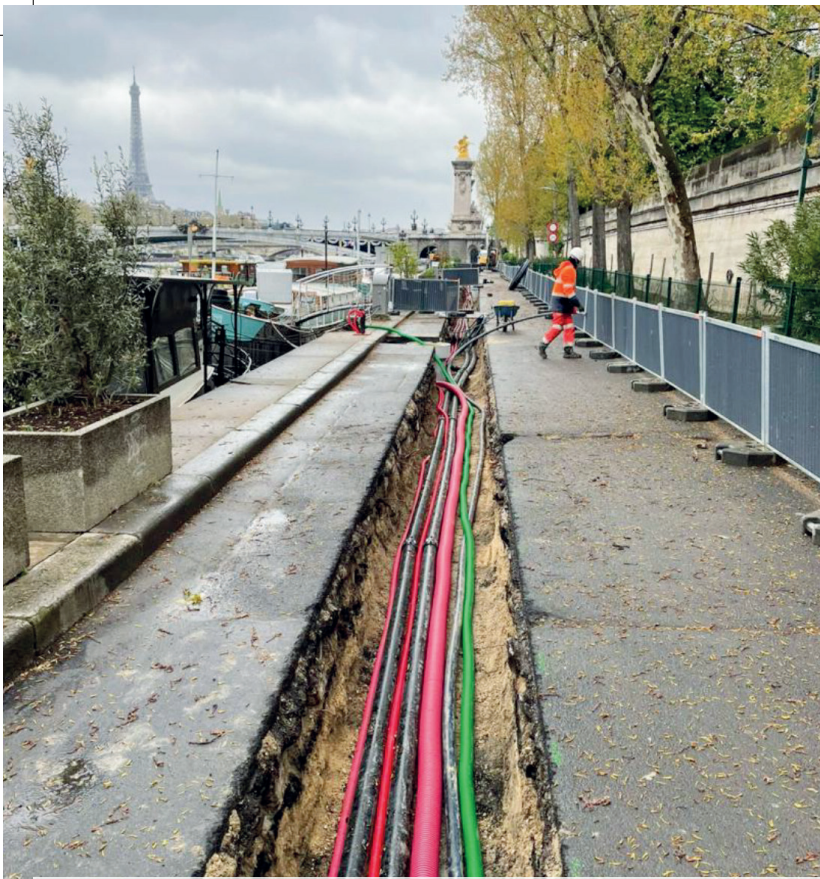
Pose du réseau d'assainissement sous vide
