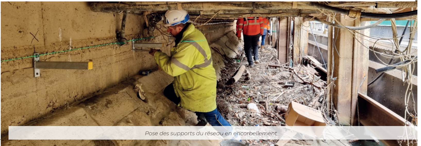
Pose du réseau de vide sous le pont Alexandre III
